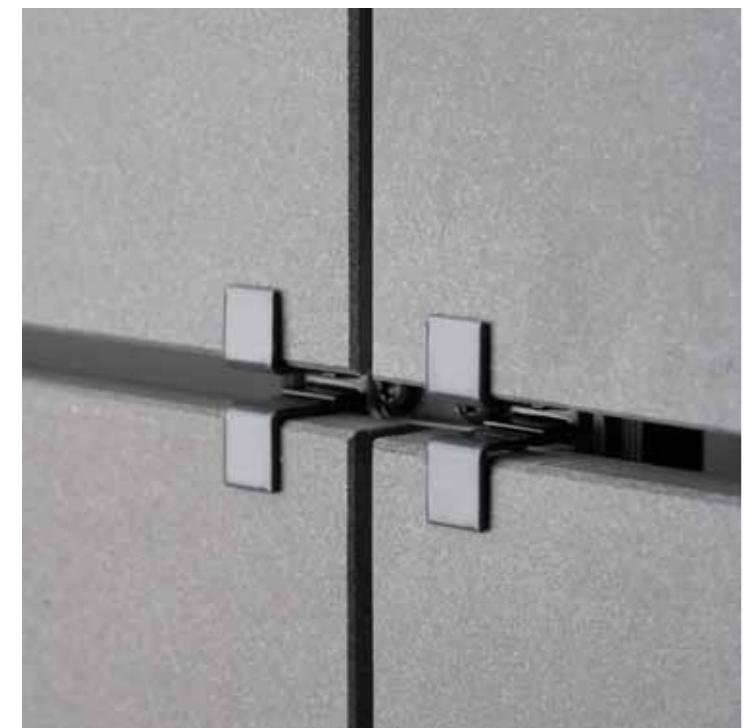
Bei einer sichtbaren Befestigung werden Mosa-Platten einfach mit einem Klammersystem auf einer Unterkonstruktion befestigt. Die Klammern bleiben sichtbar, werden in die Fassadenkonstruktion integriert, und können mit passender Farbe beschichtet geliefert werden.
