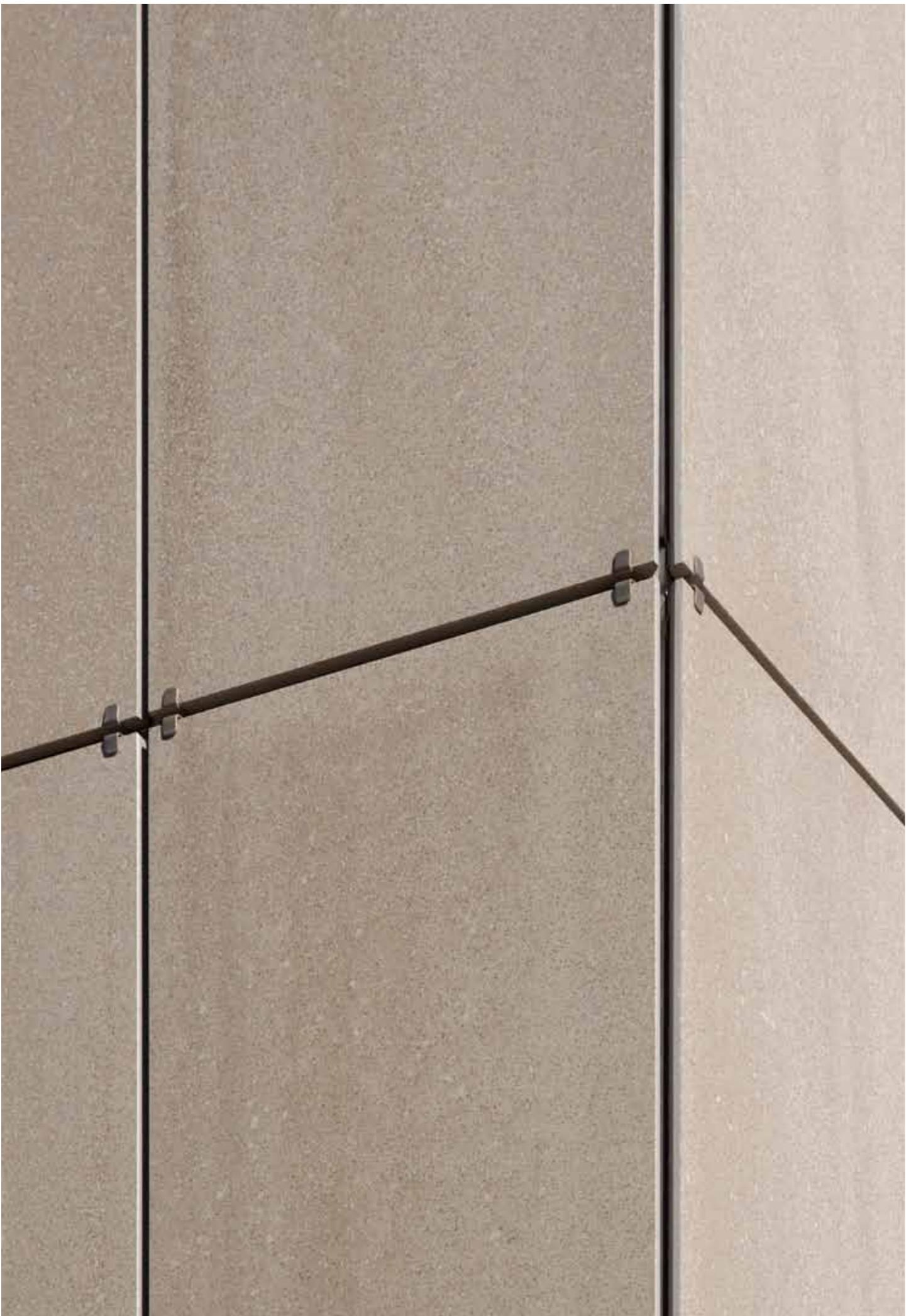
Aansluitingen bij hoeken, neggen, daken of andere bouwelementen zijn bepalend voor de totale uitstraling van het tegelvlak. Mosa Facades kent die details en levert speciale elementen die zorgen voor een naadloze aansluiting. Met de open hoeken, facethoeken en geïntegreerde hoekstukken realiseert u een perfect en ritmisch gevelbeeld. Mosa Facades adviseert u graag over de mogelijkheden en leverbare oplossingen voor uw project.
